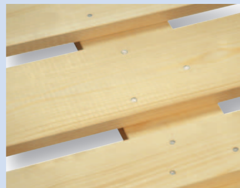
Pas de flèches et pas de moisissures importantes
